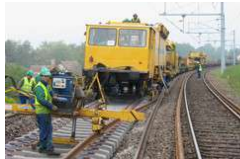
Longs Rails soudés sur traverses béton
