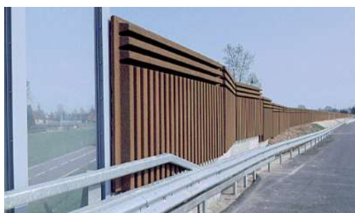
mur anti-bruit le long d'une autoroute
